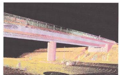
Beeindruckend: Punktewolke einer Brücke (Bildnachweis: Autor)
