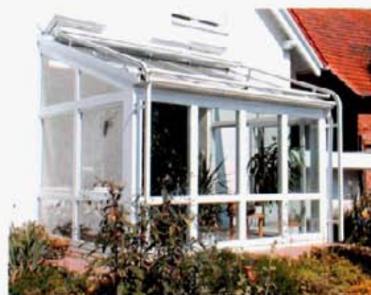
Funktionierender Blend- und Hitzeschutz durch Wintergartenmarkise und nichttransparente Lüftungsklappen
