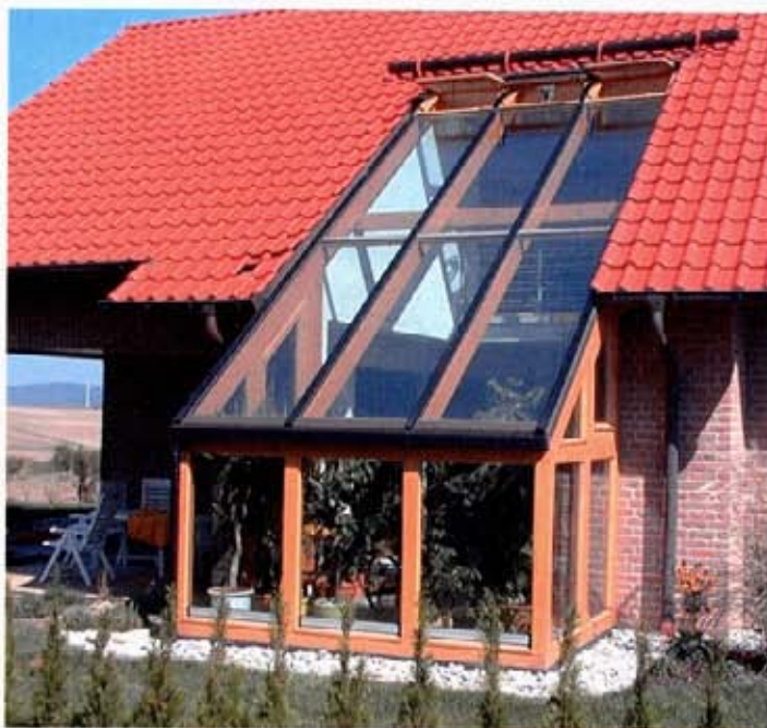
Thermisch gesehen optimal: Ein ins Wohngebäude eingeschlossener Wintergarten
