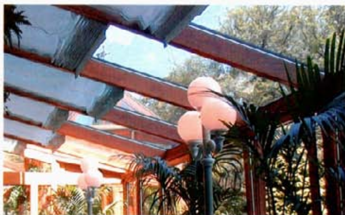
Blendschutz durch gefaltete Stoffbahnen
