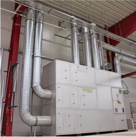
/ Herz der eingesetzten Trocknungstechnologie: Hygrex-Kältetrockner mit Kompressor und Verdampfer
